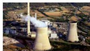
Centrale thermique (Gardanne, France)
